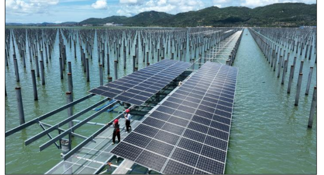
14 Teknisyenler, Fujian eyaletinin Dongshan ilçesindeki bir güneş enerjisi çiftliğinde fotovoltaik paneller kuruyor. (Fotoğraf: XINHUA)
